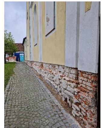
Das freigelegte Bruchstein- und Ziegelmauerwerk ist stellenweise ertüchtigt worden. Als Sockelputz kommt ein Salztransportputz von der Firma MC-Bauchemie zur Anwendung. Dieses Putzsystem sorgt dafür, dass in Wasser gelöste Salze an die Putzoberfläche transportiert werden. Anschließend ist die Sanierungsfläche mit dem KEIM Purkristalat-System getüncht worden. Im historischen Dachstuhl sind lediglich konstruktive und temporäre Maßnahmen umgesetzt worden.
